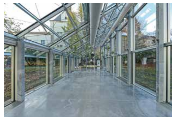
Průhled od vchodu do skleníku
